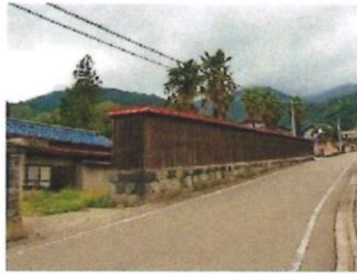
▲道路から板塀を見る
